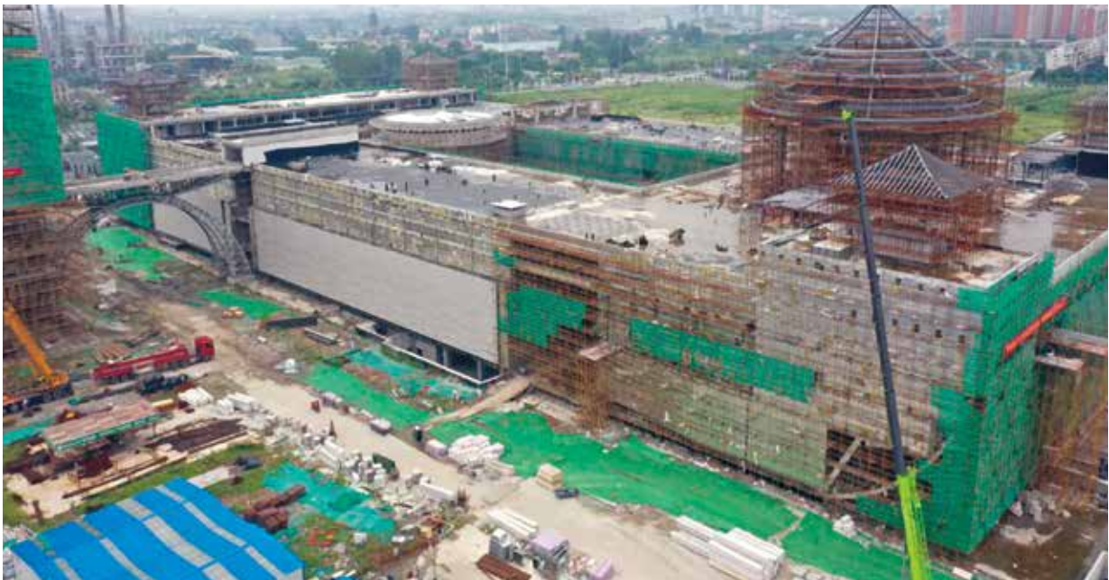
2020年5月28日，中国大运河博物馆（筹）主体结构封顶，由1.85万吨钢构件打造的大运河博物馆“金属身”开始全景呈现。
